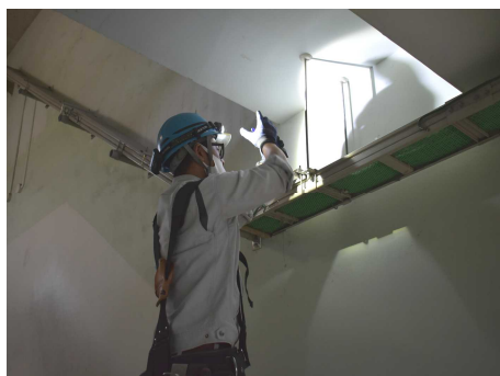
校内無線 LAN の工事
