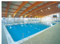
多目的プール
