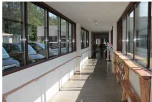
④内部仕上(A評価) 代表写真: 渡り廊下 所見: 17年経過で、良好。
