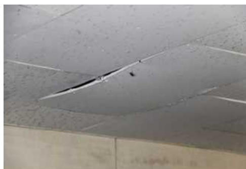
⑥屋内運動場 内部仕上(C評価) 代表写真:器具庫天井材の浮き 所見:37年経過で、経年劣化。
