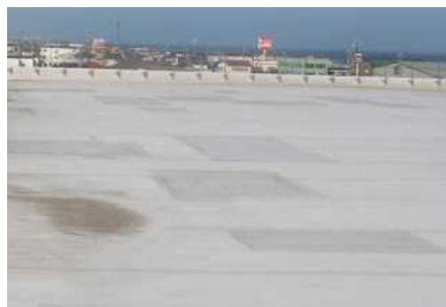
④屋内運動場 屋根・屋上(A評価)
