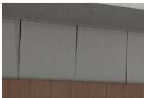
③内部仕上(B評価) 代表写真:壁クロスの剥がれ 所見:36年経過で、経年劣化。
