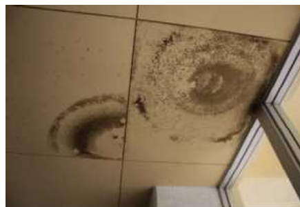
④校舎4～8 内部仕上(C評価) 代表写真: 児童玄関風除天井の水シミ 所見: 41年経過で、広範囲に劣化。
