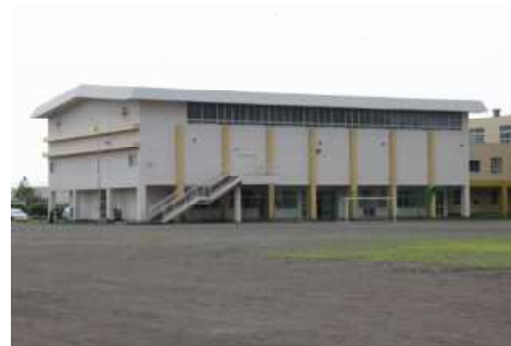
⑥屋内運動場 外壁(A評価) 代表写真:外壁 所見:良好。
