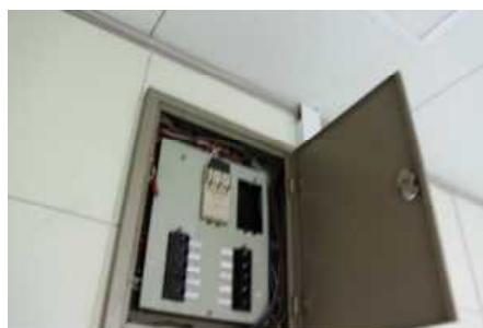
③校舎1～3 電気設備(C評価) 代表写真: 分電盤 所見: 47年経過。
