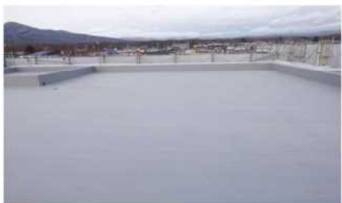
③校舎6～10 屋根・屋上(A評価)
