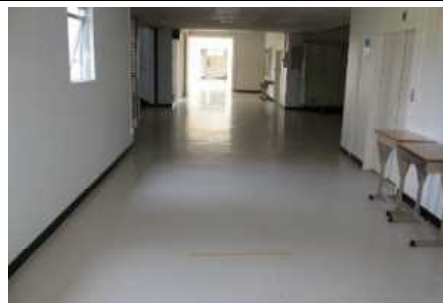
②校舎2 内部仕上(A評価) 代表写真:廊下 所見:良好。
