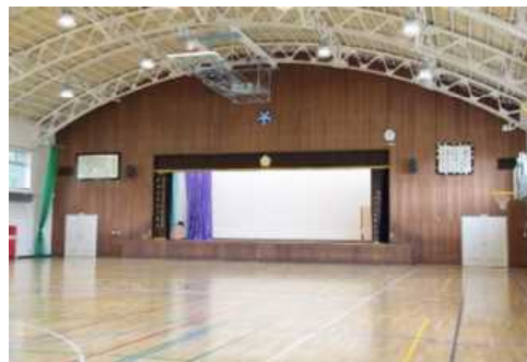
⑥屋内運動場 内部仕上(A評価) 代表写真:アリーナ 所見:6年経過で、劣化はみられない。
