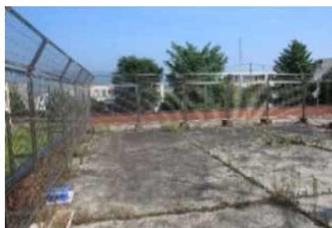
②校舎 屋根・屋上(C評価)
