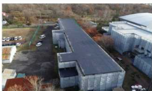
①校舎1～5 屋根・屋上(A評価)
