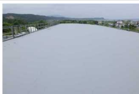
②屋根・屋上(A評価) 代表写真:屋根防水 所見:劣化はみられず、良好。
