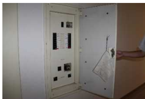
④電気設備(B評価) 代表写真:分電盤 所見:36年経過で、経年劣化。
