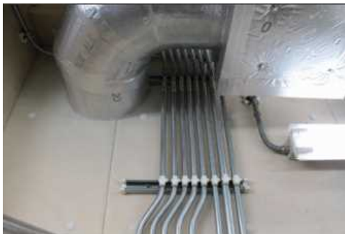
⑤電気設備(A評価) 代表写真: 電気配線 所見: 17年経過。
