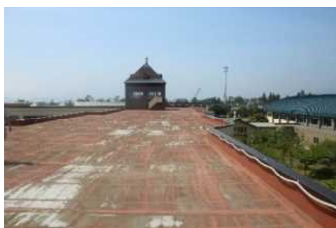
①校舎 屋根・屋上(C評価)
