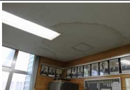
②校舎1 内部仕上(A評価) 代表写真:校長室の天井の水シミ 所見:17年経過で、全体的には良好。
