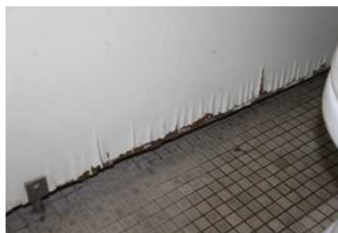
②校舎 内部仕上(C評価) 代表写真:便所ブースの劣化 所見:43年経過で、経年劣化。
