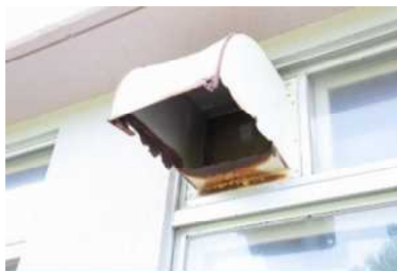
⑤校舎6～9 機械設備(C評価) 代表写真:鉄板製フードの腐食 所見:47年経過で、経年劣化。
