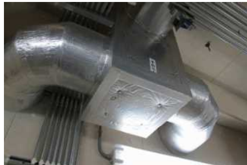
⑥機械設備(A評価) 代表写真: 換気ダクト 所見: 17年経過。
