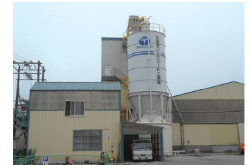
① コンクリート工場
