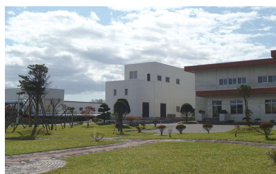
平成2年に運転開始した若山浄化センター
