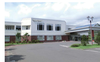
平成6年に完成した総合福祉センター（しんた21）
