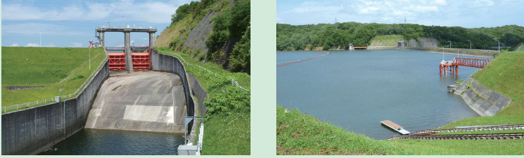
ほろへつ 幌別ダム
