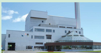
①クリンクルセンター
