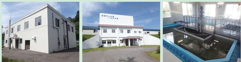
① 幌別浄水場
