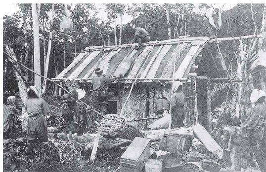
④開拓する人々が小屋を建てている様子 ／『明治・大正期の北海道(写真編)』
