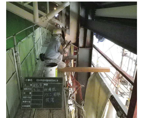
④ 学校の耐震補強工事の様子
